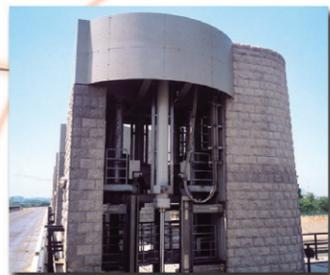
巨大なダムゲートの開閉には油圧ユニット／油圧シリンダが利用されています。
