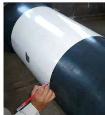
図1.2.9-46 管の軸方向及び取付間隔のけがき
