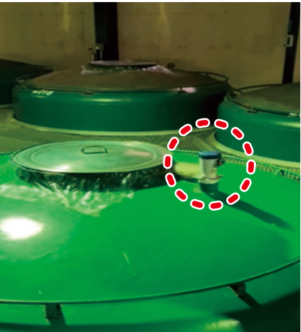
● 検尺口（50Aノズル）に設置
