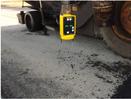
路盤基準施工
