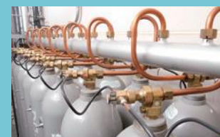
水・泡消火が適さない工場、オフィスビル、美術館、立体駐車場などの施設で活躍するガス系消火設備
