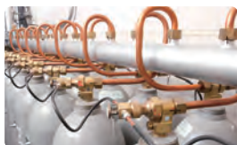
水・泡消火が適さない工場、 オフィスビル、美術館、 立体駐車場などの施設で 活躍するガス系消火設備
