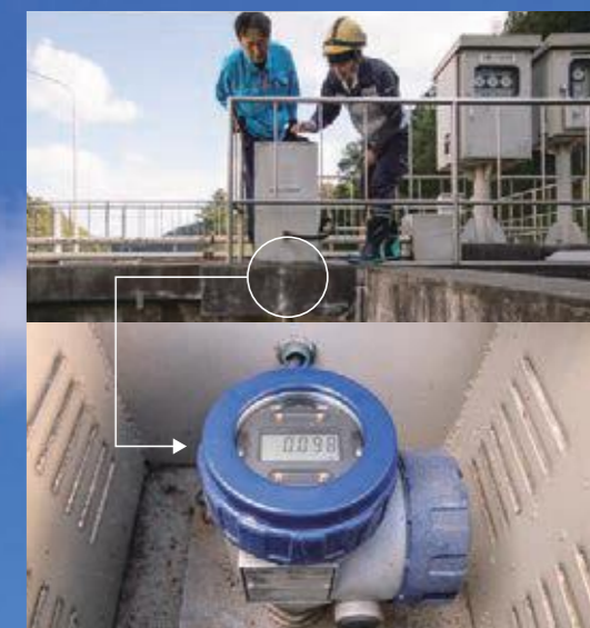
各貯水池は管と違い水面が露出しているため、別方式で流量を算出している。算出の際に必要な水位計測に使用されているのは東京計器の電波式レベル計。
