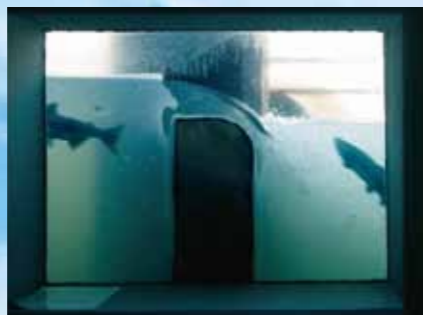
利根大堰にはサケやアユが遡上できるよう「魚道」が設置されており、魚道の脇の地下にある観察室からは、春(5月頃)にはアユが、秋(10月~12月)にはサケの遡上が観察できます。
