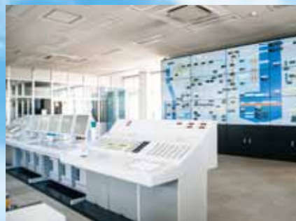
利根導水総合事業所内の中央操作室 ここでは24時間の監視体制が敷かれ、利根導水の安全を管理しています。
